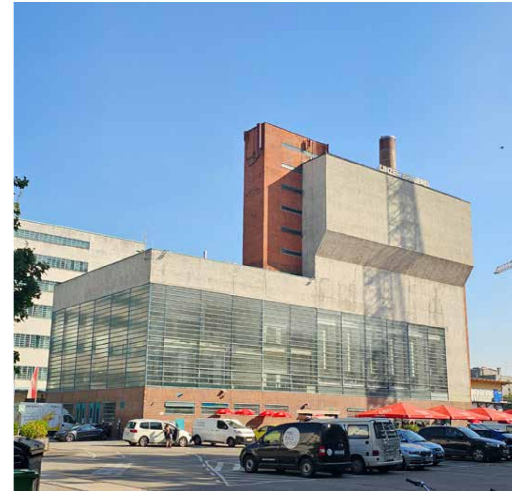
Beispiel für den wirtschaftlichen Strukturwandel: Umbau der alten Tabakfabrik in der Stadt Linz zum Technologie- und Innovationszentrum.
